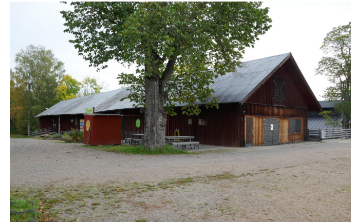
Byggnader tillhörande det gamla valsverket vid Wij bruk.
